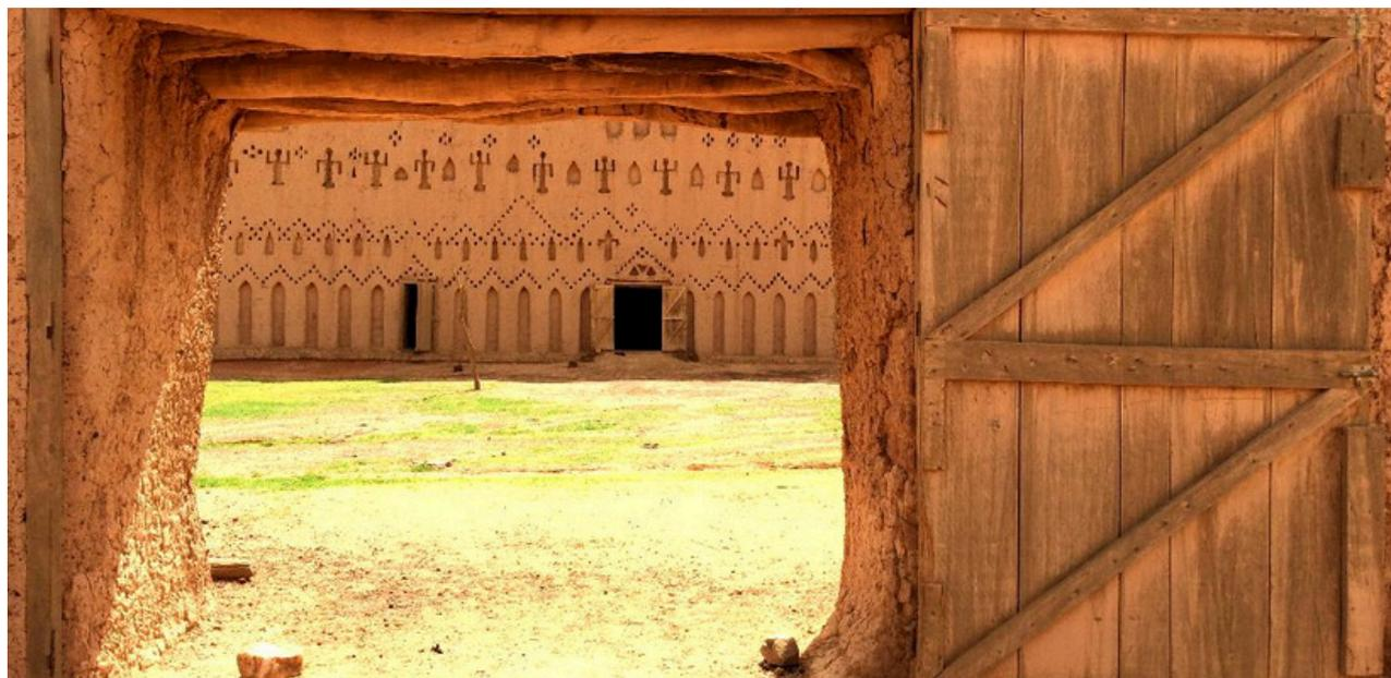
**Il degrado del complesso** ha oggi raggiunto proporzioni molto vaste, a causa delle condizioni climatiche a cui si aggiunge l'assoluta mancanza di manutenzione, che per questi edifici fatti di 'banco', come viene chiamato in loco questo particolare tipo di fango, è fondamentale, tanto che è necessario intervenire sulle strutture almeno una volta ogni anno.
